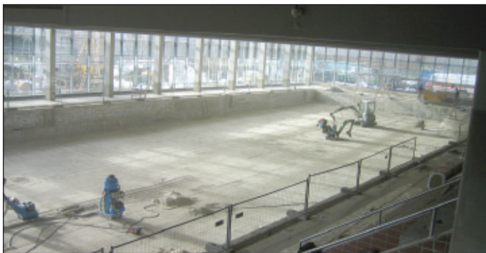
Die Renovierung des Europabades verzögert sich.
